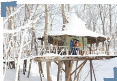
吊り橋付ツリーハウスの定期改修
